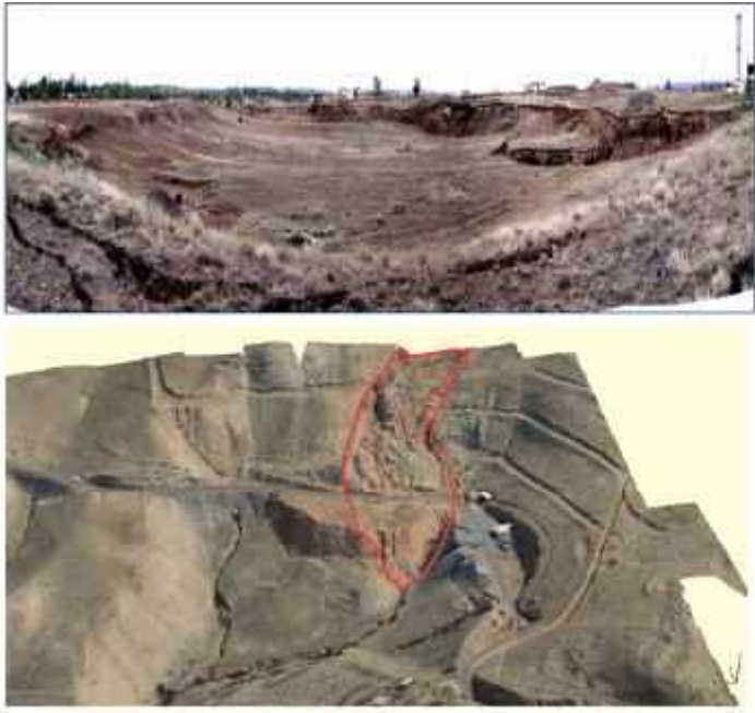
Оседание, оползень и провал земной поверхности над угольной шахтой
