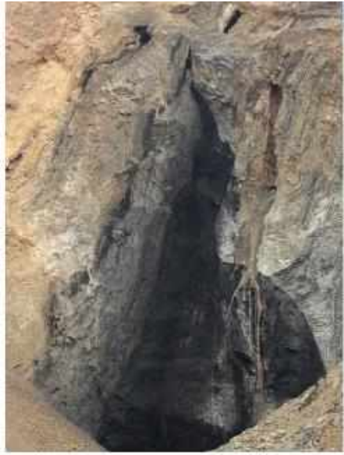
Оседание, оползень и провал земной поверхности над угольной шахтой
