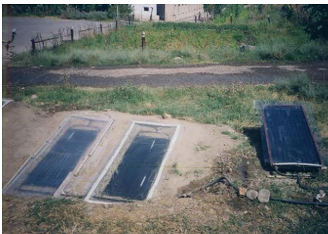
а) коллектор в грунте
