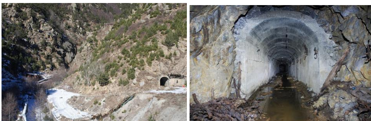
Рисунок 3.1 - Штольня Садонского полиметаллического рудника
