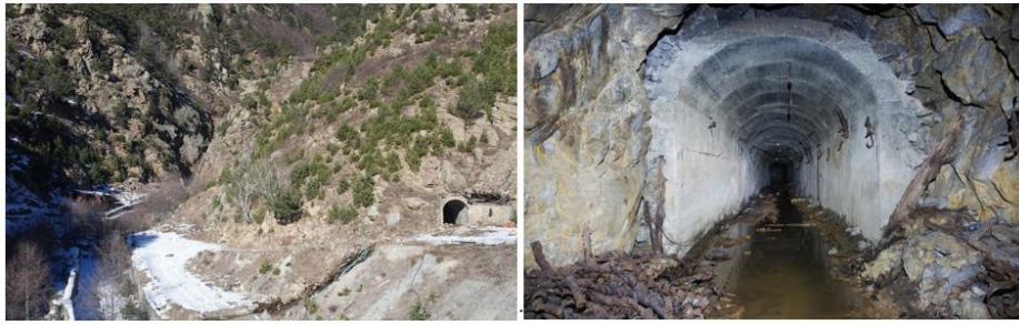
Рисунок 3.1. Штольня Садонского полиметаллического рудника.
