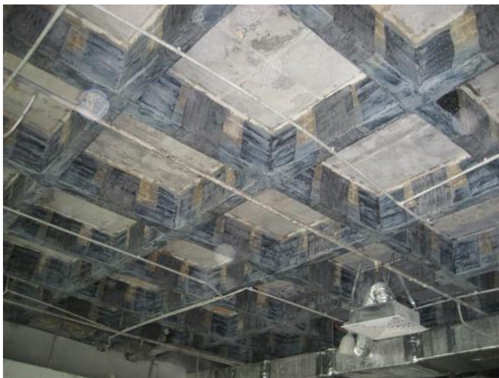
Рис.1.11. Усиление перекрытий углехолстом
