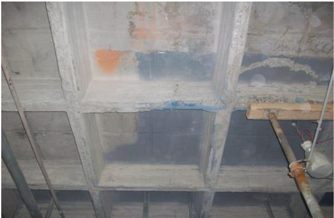
Рис. 1.8. Усиление перекрытий в здании торгового центра
