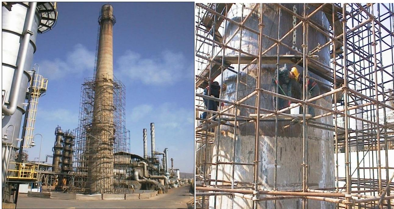
Рис. 1.3. Усиление кирпичной трубы в Бразилии
