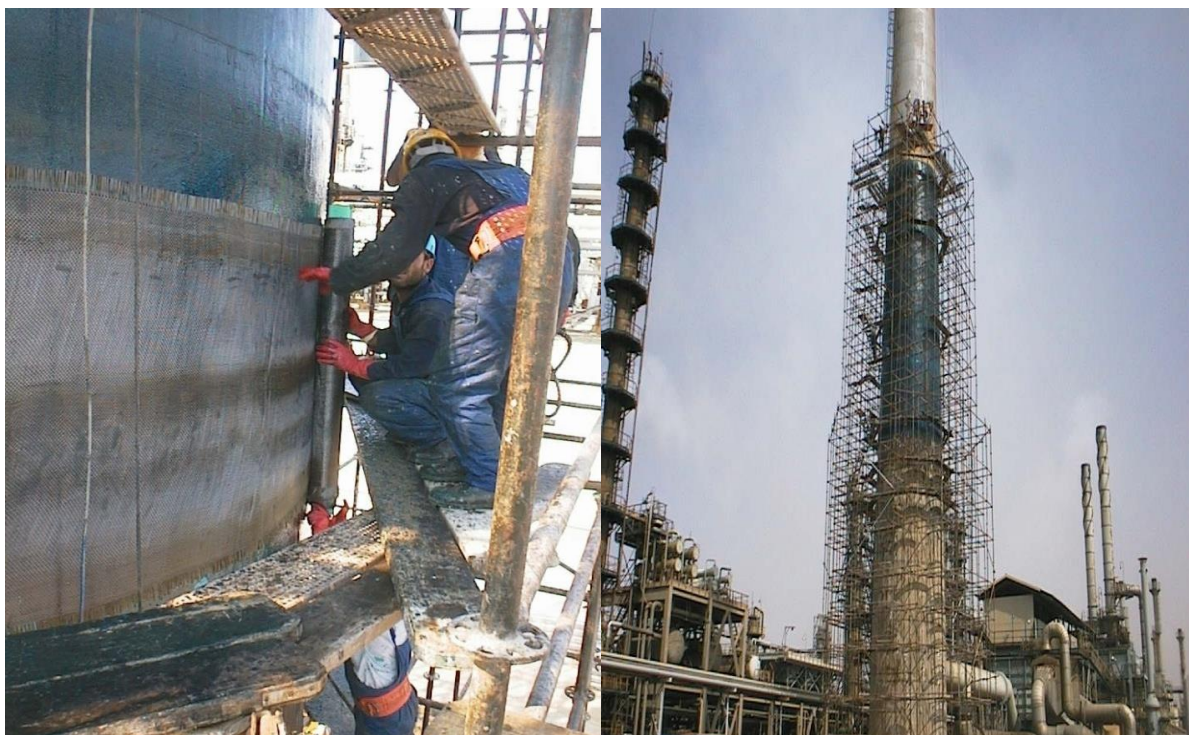
Рис. 1.3. Усиление кирпичной трубы в Бразилии
