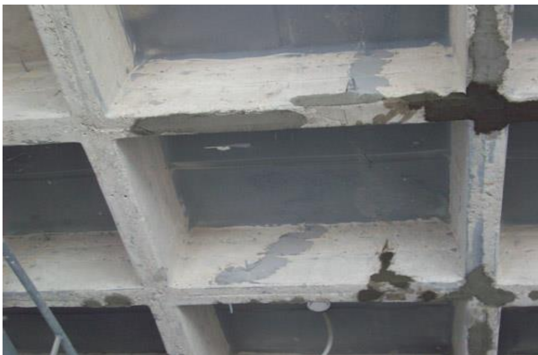
Рис. 1.9. Восстановление поврежденных участков бетона и установка пакеров для инъецирования
