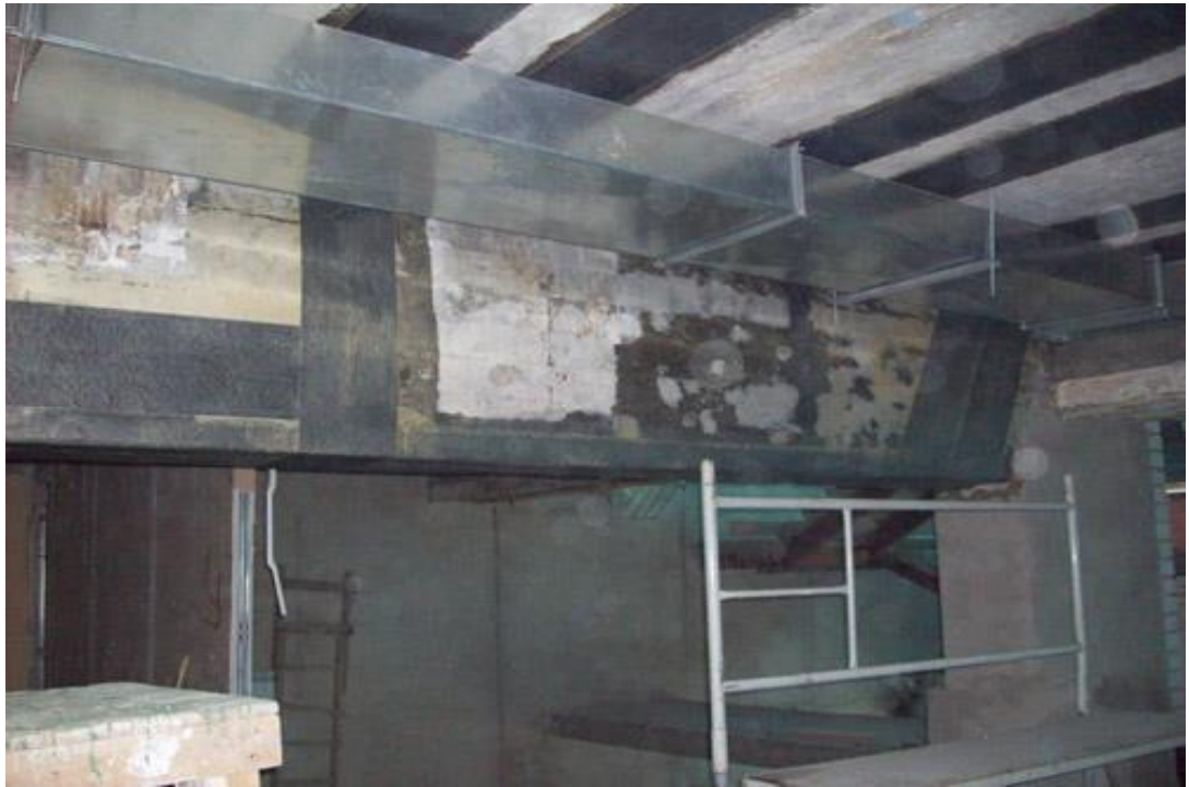
Рис. 1.7. Усиление конструкций в общественном здании в Твери с использованием углехолста
