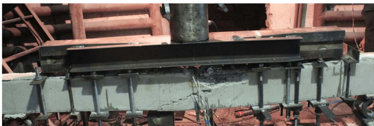
Рис. 3.68. Разрушение балки БШ-4д при динамическом нагружении
