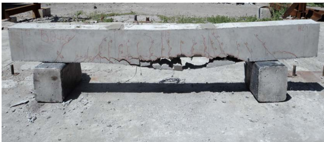
Рис. 3.4. Разрушение балки от отрыва защитного слоя бетона ламинатом
