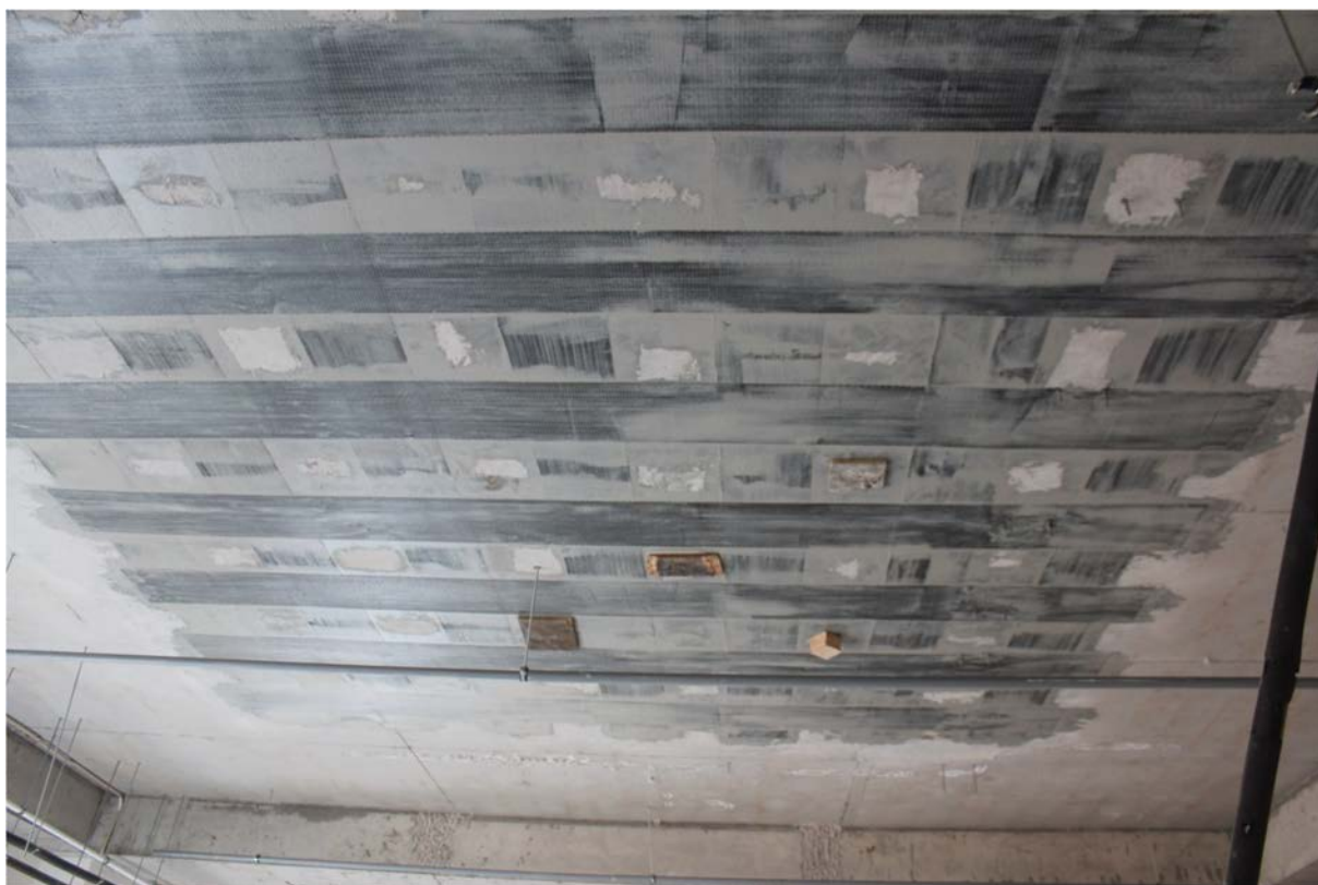
Рис. П1.4.3. Общий вид усиления плиты перекрытия здания на пр. Сейфуллина
