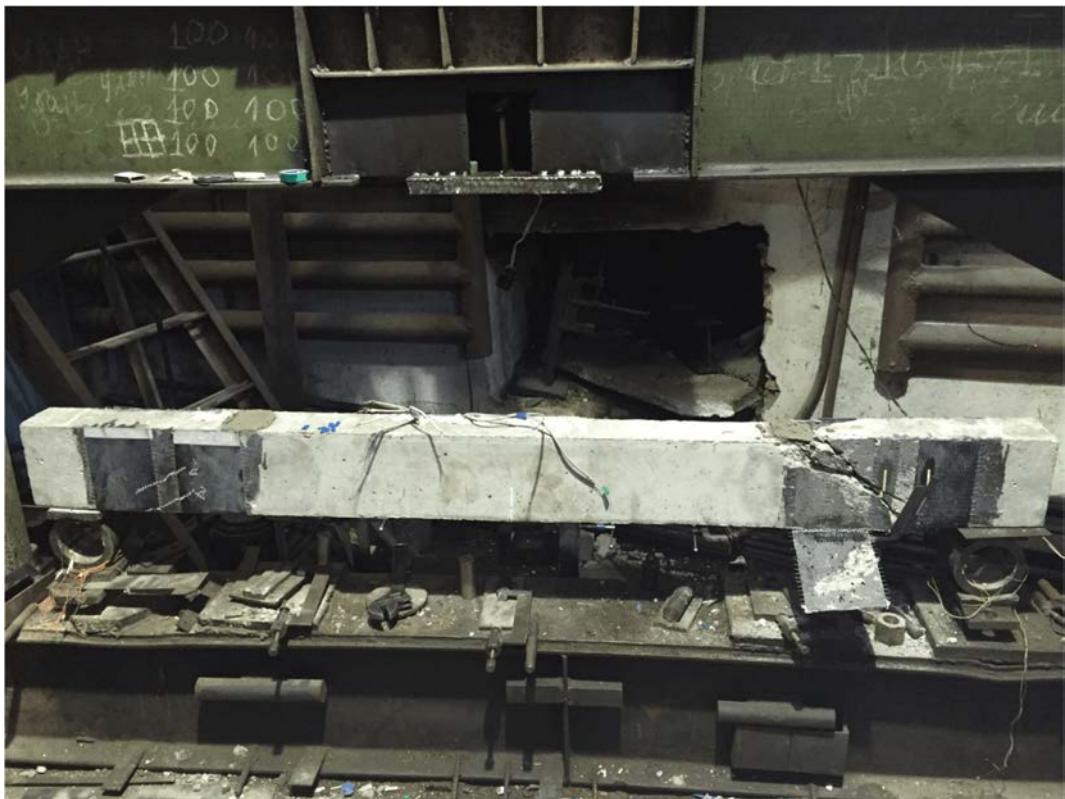
Рис. 3.21. Разрушение опорной зоны после испытания и после снятия сеток балки BQ11-3
