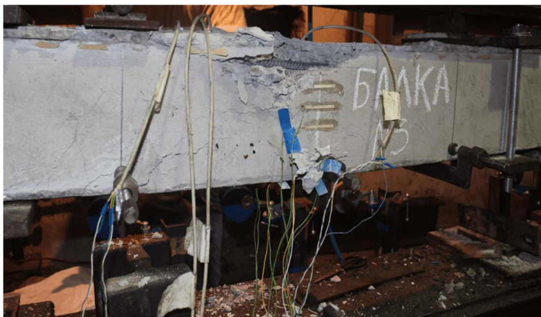
Рис. 3.4. Вид сбоку участка поврежденного защитного слоя бетона балки
