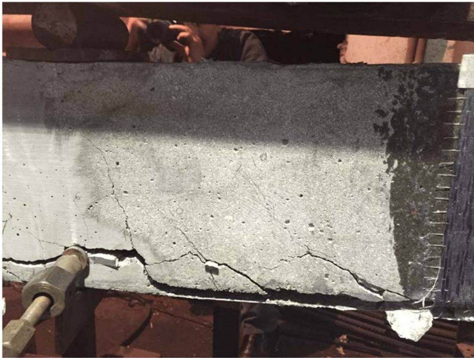
Рис. 3.9. Фрагмент зоны разрушения балки БИ-1с
