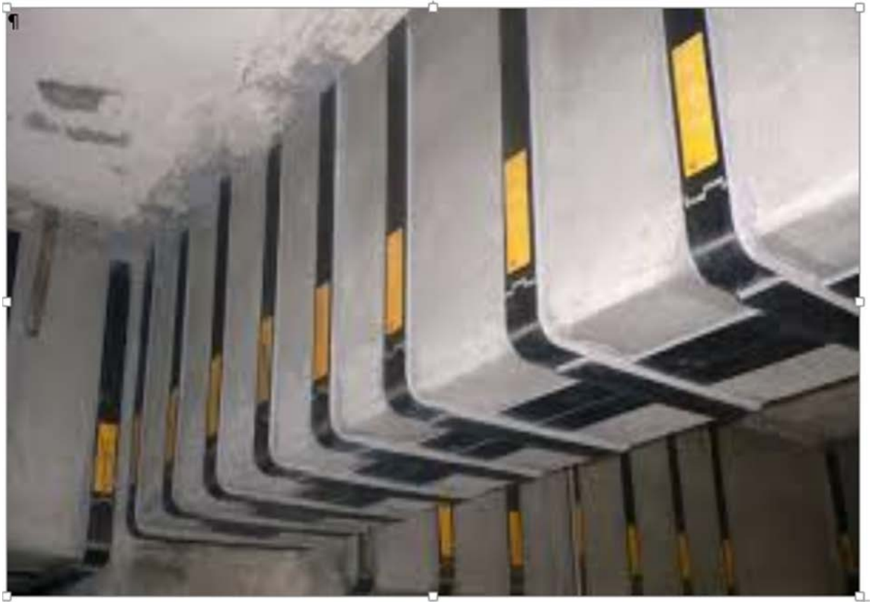
Рис. 1.4. Усиление растянутой зоны и прочности по поперечной силе ригеля
