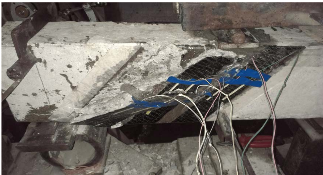
Рис. 3.18. Разрушение по поперечной силе балки, имеющей наклонные фиброармированные полосы из сеток на левом конце
