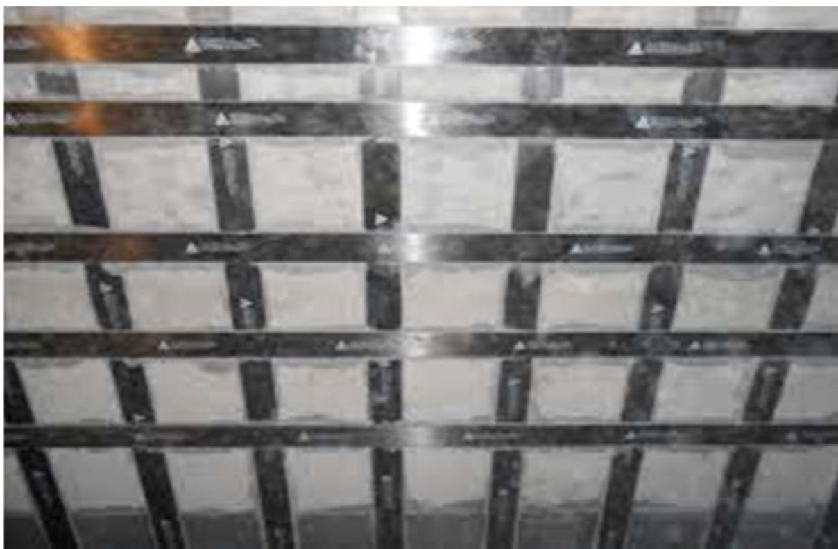
Рис. 1.3. Усиление плиты перекрытия фиброармированными лентами ламелей
