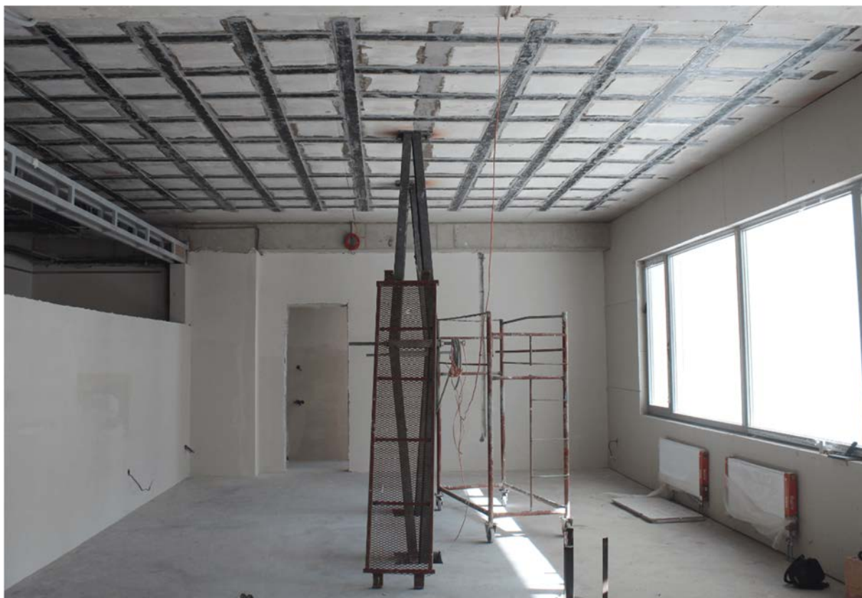
Рис. П 1.2.5. Общий вид усиления плиты перекрытия здания Блока «С»
