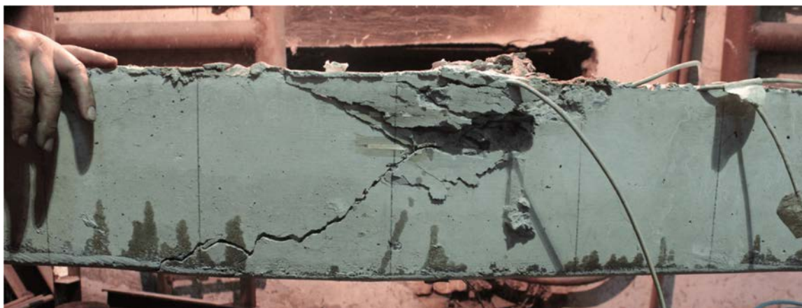
Рис. 3.56. Фото разрушения пролетной части балки БШ-1д
