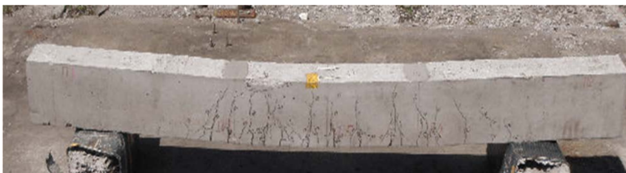
Рис. 3.1. Разрушение железобетонной балки, не имеющей усиления
