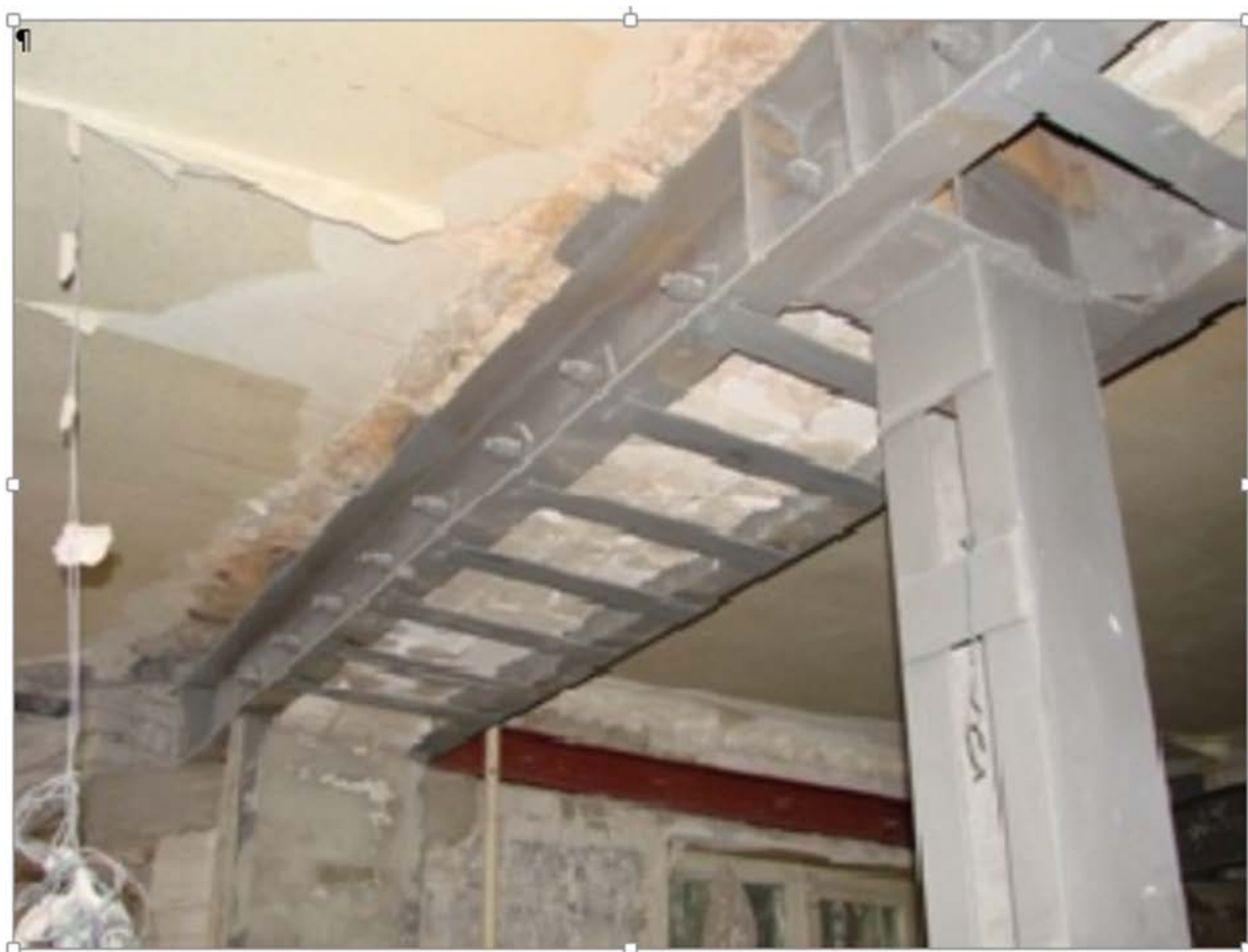
Рис. 1.2. Усиление железобетонной конструкции прокатными стальными элементами.
