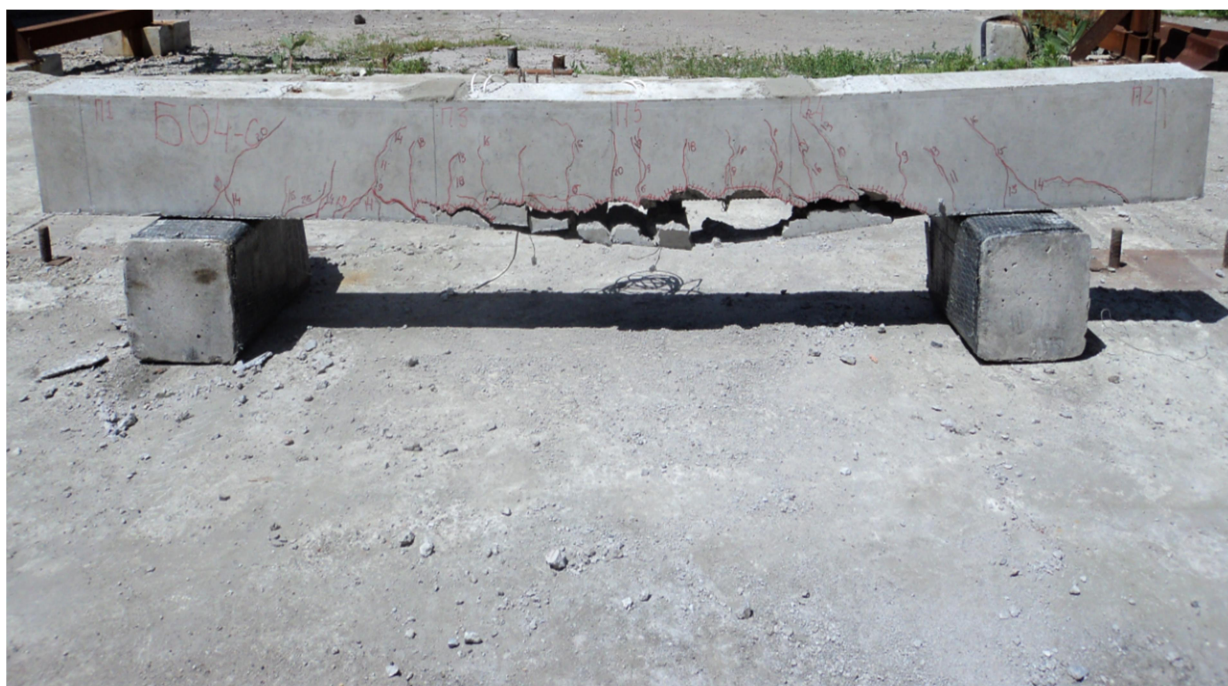
Рис. 5. Разрушение балки в зоне чистого изгиба с отрывом защитного слоя бетона
