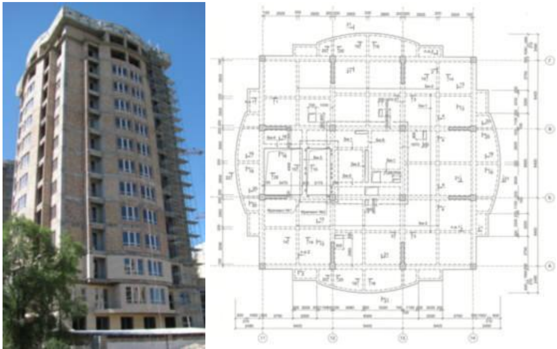
Рисунок 4.5 – Общий вид и конструктивная схема в плане 12-этажного здания
