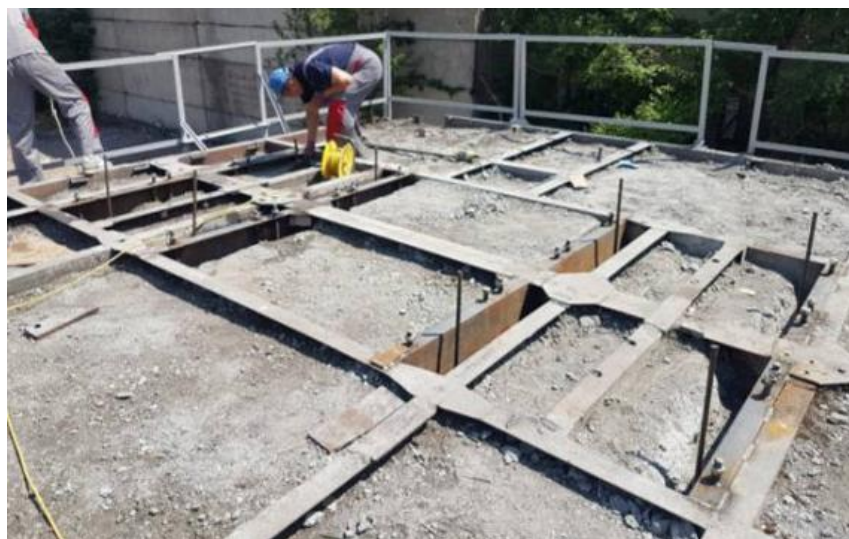
Рисунок 2.25 – Общий вид рамы в процессе ее закрепления на платформу
