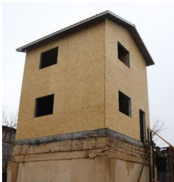
Рисунок 5.42 Здание из легких стальных конструкций в разном состоянии обшивки
