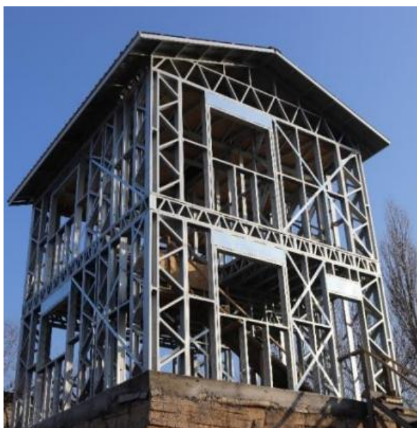
Рисунок 5.42 Здание из легких стальных конструкций в разном состоянии обшивки
