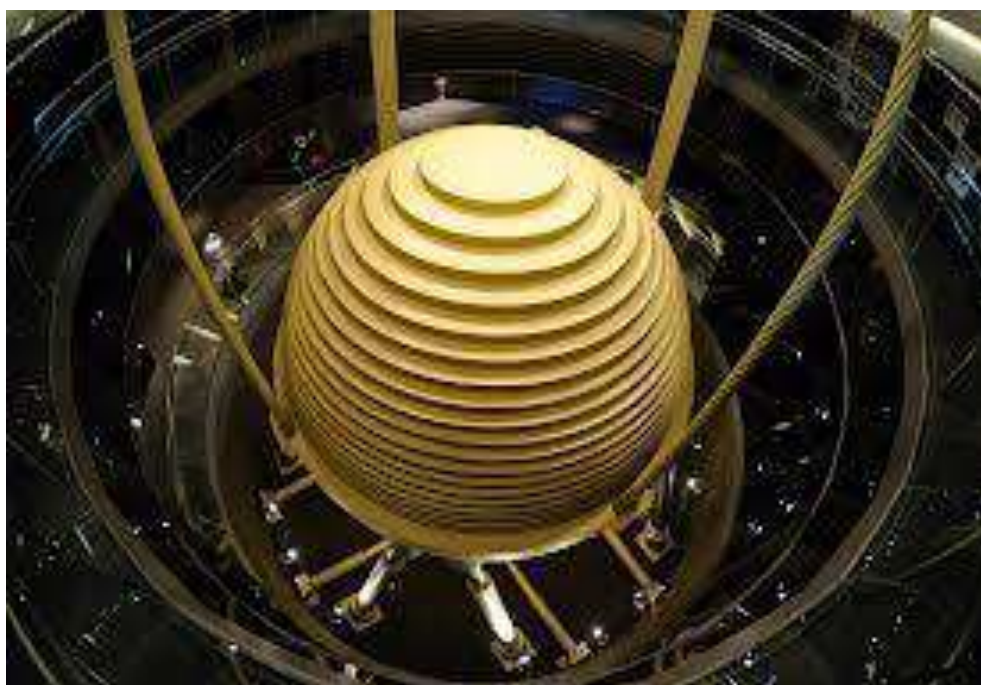
Рисунок 3.1 - Инерционный демпфер высотного здания
