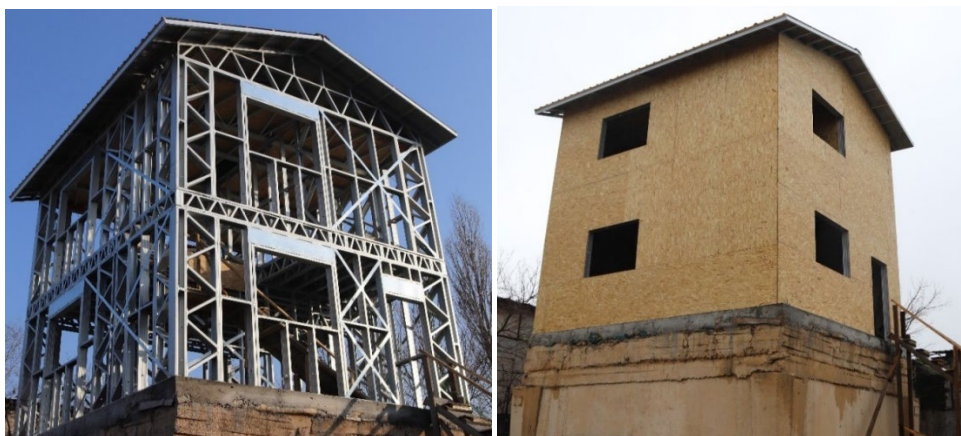
15-сүрөт – Жеңил болот конструкциядан жасалган (капталбаган жана капталган) эки кабаттуу имарат
